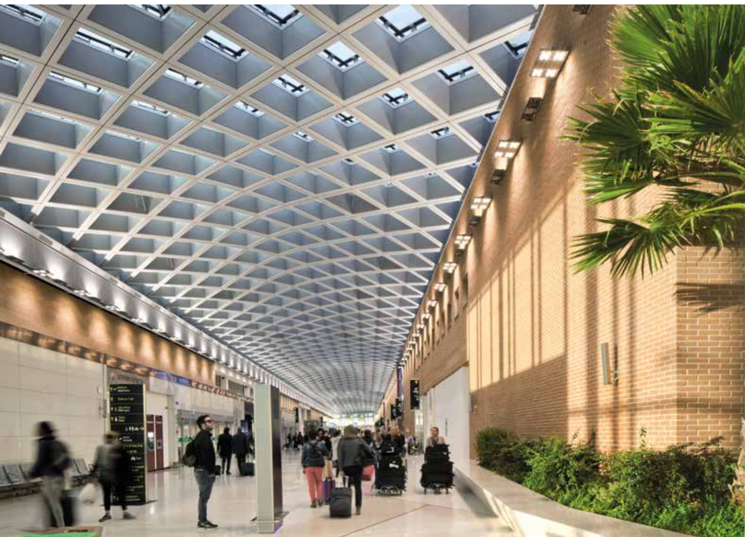
La nuova galleria d'ingresso al terminal passeggeri
